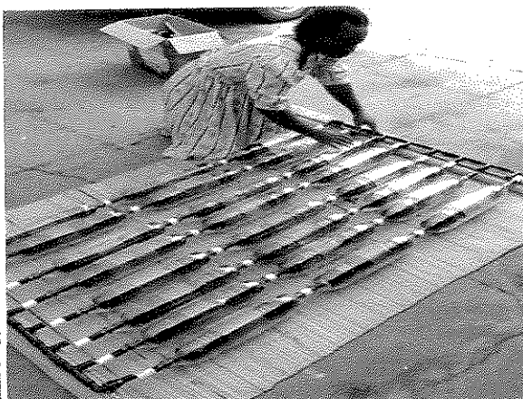
Fig. 4.1- Ensaio da montagem do colector
