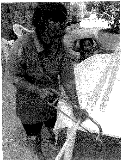
Fig. 3. – Corte dos tubos PVC
