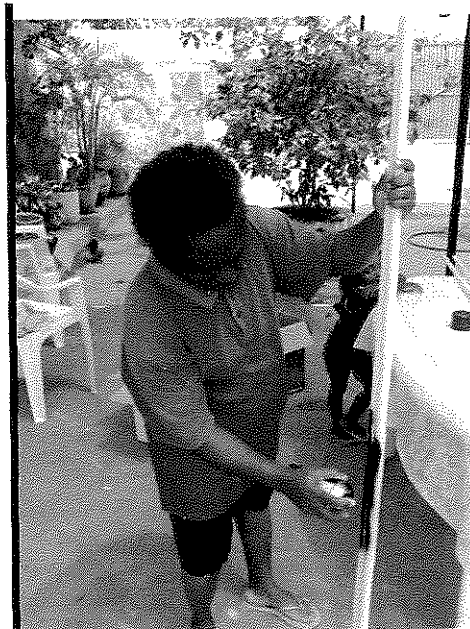
Fig. 3.1- pintura dos tubos PVC.
