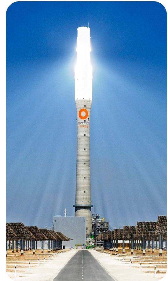
Gemasolar, Torresol Energy, Seville (Espagne)
