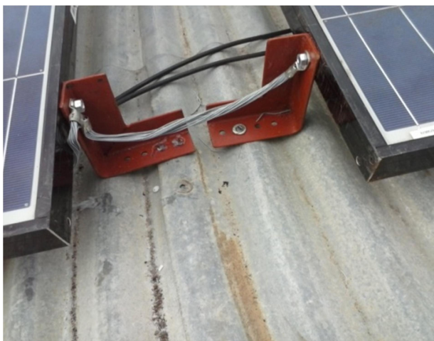
Figure 3.35: Equipotential bonding of module frames
