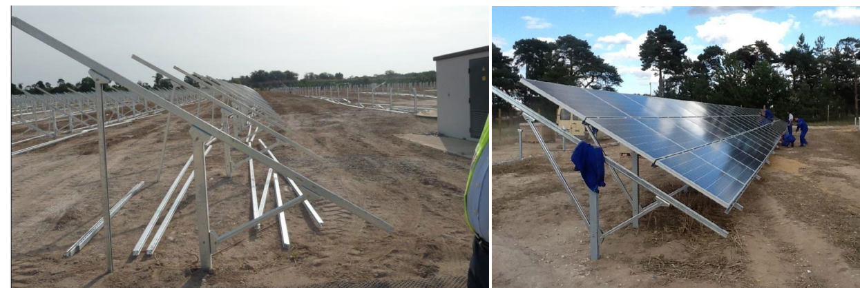
Montaža solarnih panela na zemlji
