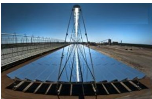
Linearni Fresnelovi kolektori kolektori - stvarni izgled
