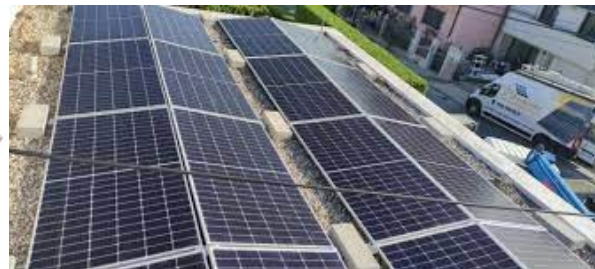
Montaža panela na ravnom krovu
