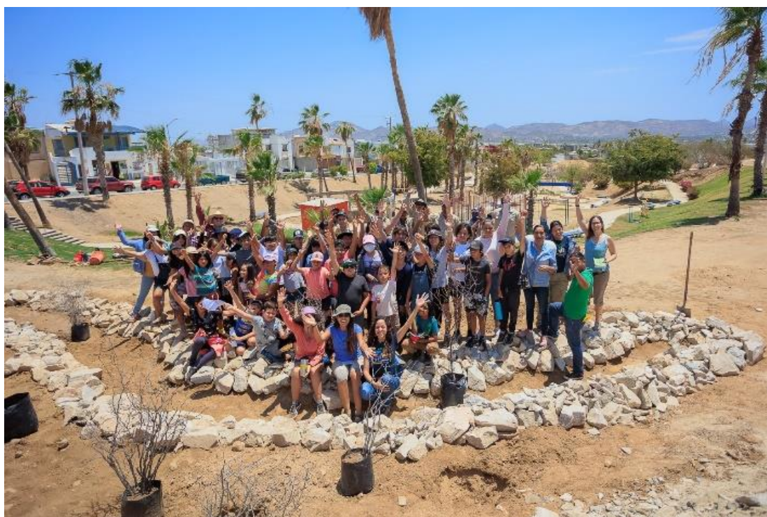
Jóvenes en la construcción de las cuencas de lluvia en el parque. Archivo: GIZ México
