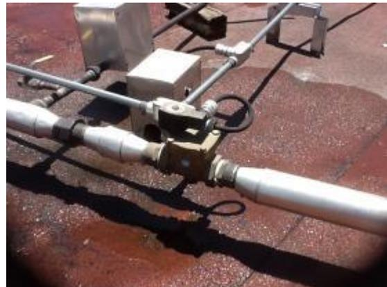
Figura 94: Fuga entre conexiones
