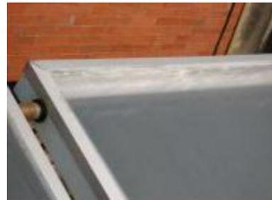
Figura 57: Interconexión de colectores
