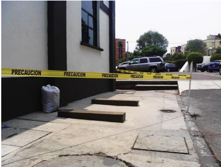
Figura 79: Durmientes rectificadas para alinear termotanque
