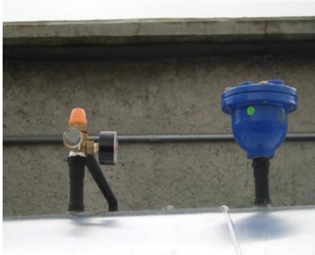
Figura 86: Válvulas de seguridad en termostanque
