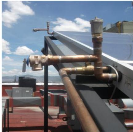
Figura 61: Válvula Liberadora de Aire y Válvula de Alivio de Presión
