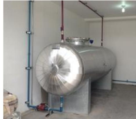
Figura 17: Termotanque fabricado a la medida
