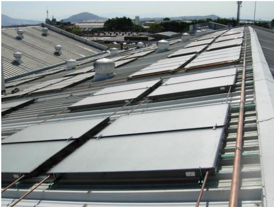
Figura 67: Ramales de carga y descarga en diferentes diámetros
