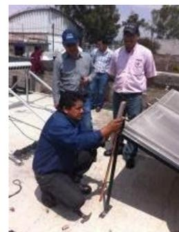
Figura 48: Nivelación de estructura
