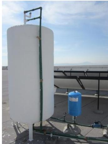
Figura 77: Fijación de termotanque vertical
