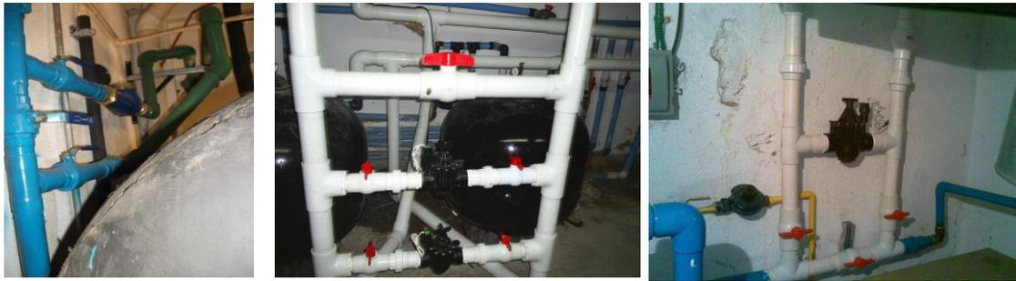
Figura 80: Bypass de agua fría, de doble punteo con válvulas solenoides y de dos vías
