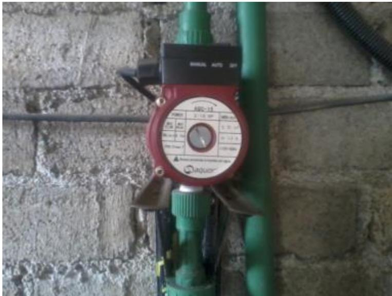
Figura 83: Elementos hidráulicos de instalación de bomba de recirculación
