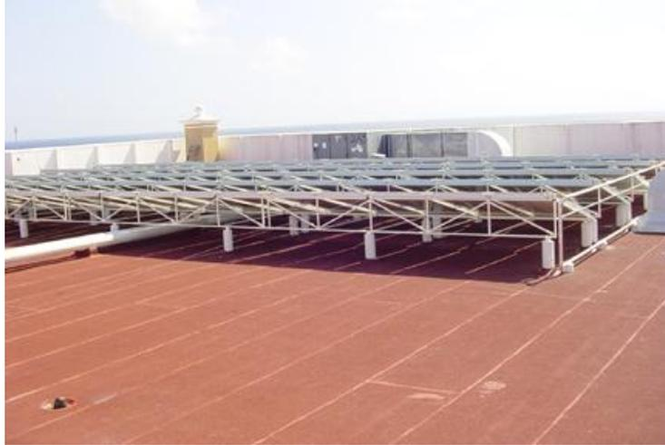
**Figura 51: Fijaciones con cilindros de cemento**
