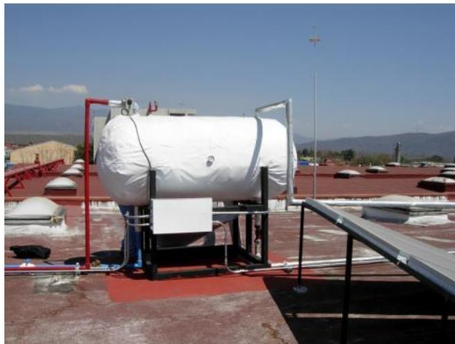
Figura 76: Fijación de termotanque horizontal
