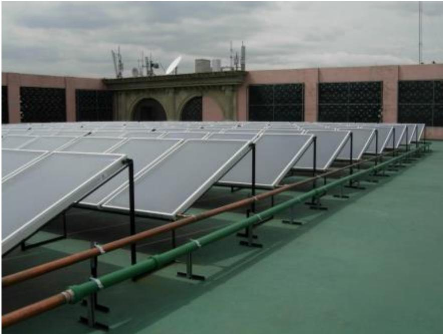
Figura 68: Conexiones alineadas respecto a la tubería
