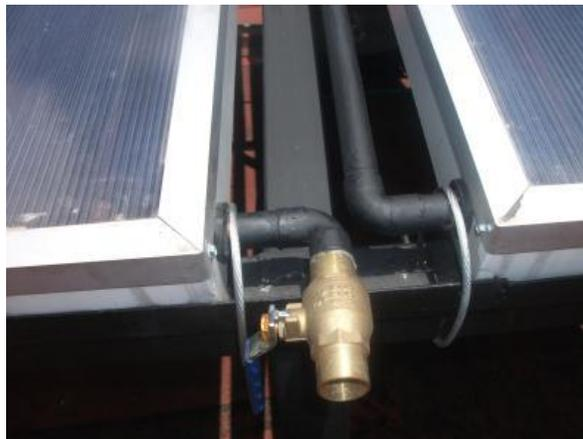
Figura 62: Válvula de drenaje o drenado
