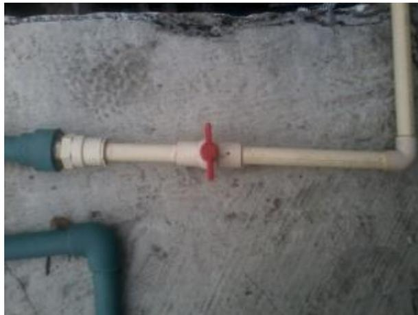
Figura 81: Válvulas de acometida de agua fría
