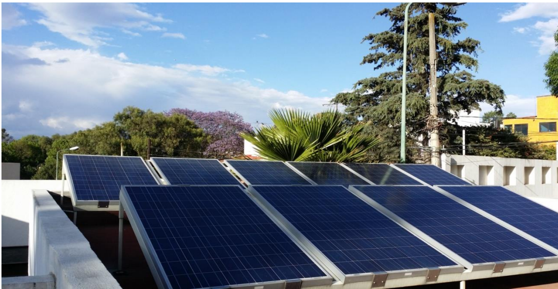
Imagen 27 Sombras provocadas por árboles sobre módulos fotovoltaicos.
