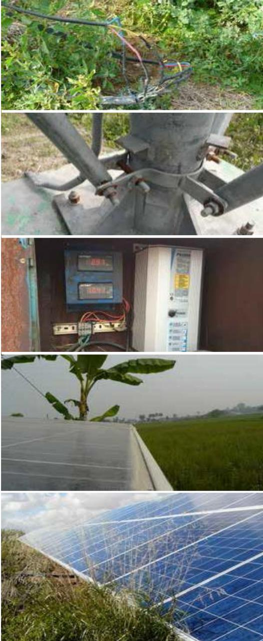
Conexión peligrosa de cables, corrosión galvánica de un sistema de seguimiento manual, capacidad limitada de disipación de calor de la carcasa corroída de un controlador; ejemplos de mantenimiento inadecuado: suciedad acumulada en el borde inferior del panel fotovoltaico, sombras sobre un panel fotovoltaico provocadas por falta de mantenimiento de la cubierta vegetal del suelo
