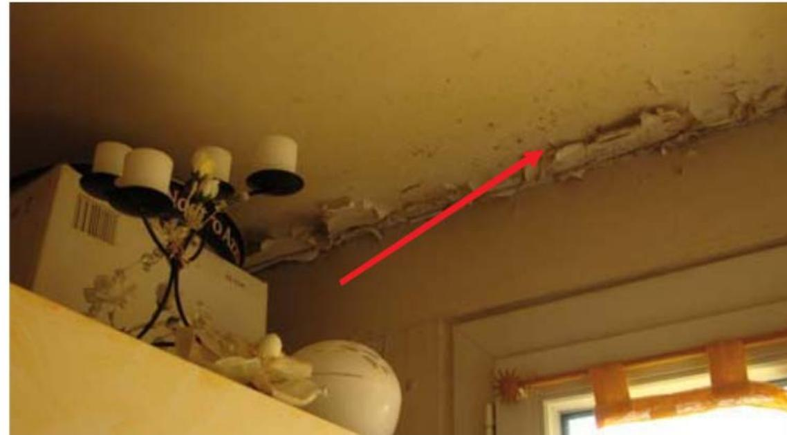
**Ecaillage de la peinture au niveau du pont thermique entre mur et le plafond**
