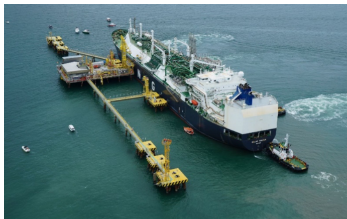
Figure 10 – Island LNG Jetty in Brazil
