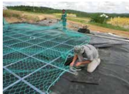
d) Instalación de la red de nylon.
