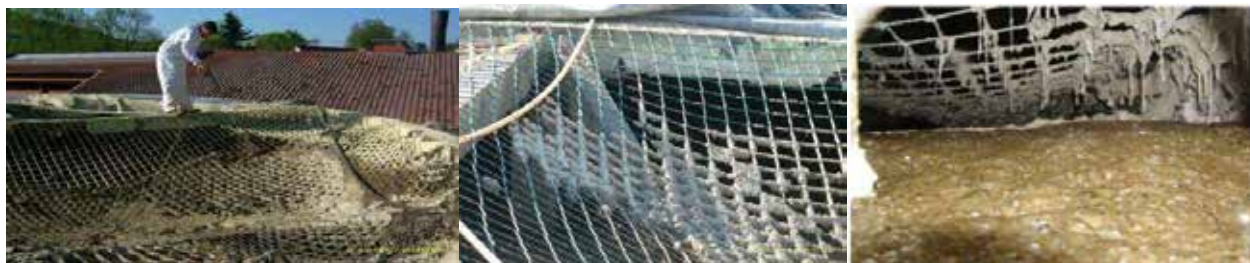
GRÁFICO 3.14. Azufre elemental ( S^0 ) depositado en la red del biodigestor
