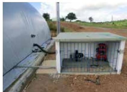
n) Cubierta para los equipos electromecánicos del gasómetro.
