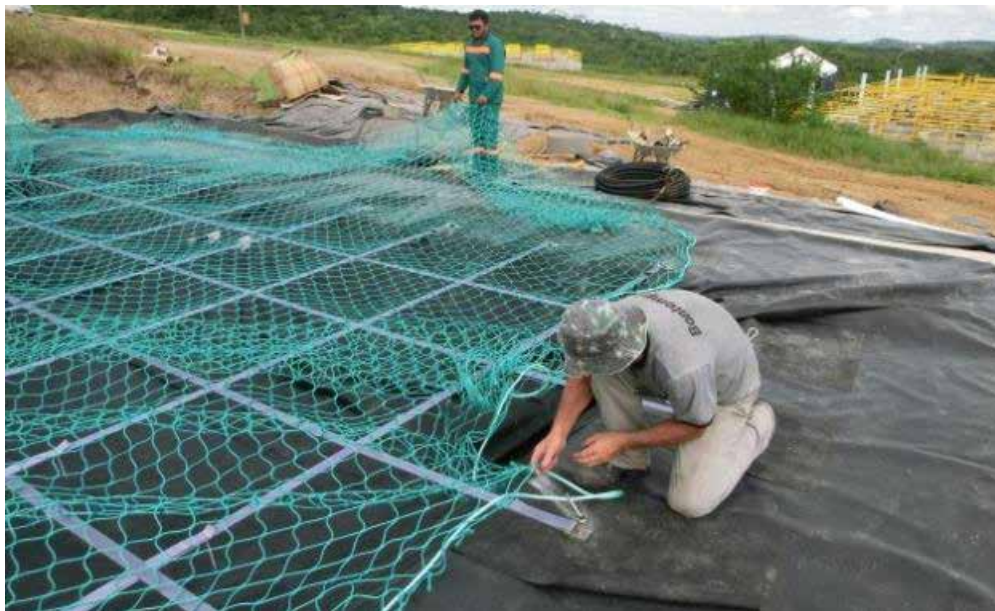
GRÁFICO 3.8. Red de nylon utilizada como área adicional de fijación para microorganismos en un gasómetro externo al biodigestor
