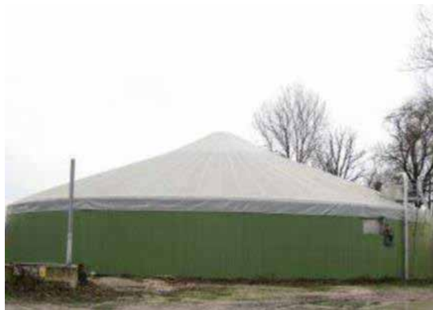
GRÁFICO 3.1. Biodigestor con desulfuración interna por microaireación
