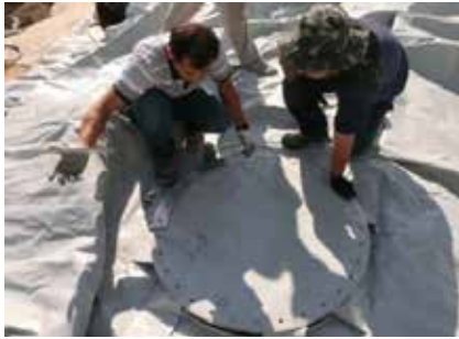
i) Instalación de entrada hombre para inspección.
