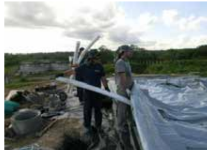
j) Colocación de los soportes que dan forma al gasómetro
