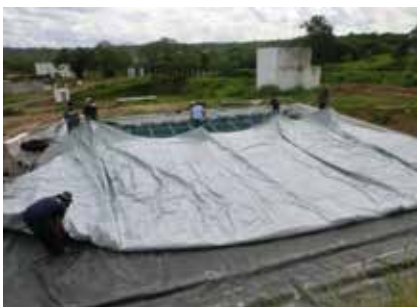
g) Instalación de la membrana interna.
