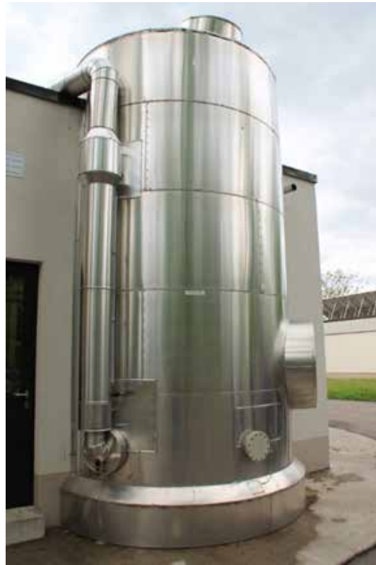
GRÁFICO 2.5. Biofiltro percolador de una PTAR en Augsburg, Alemania
