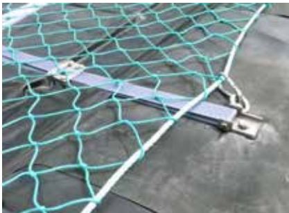
e) Fijación de la red de nylon.
