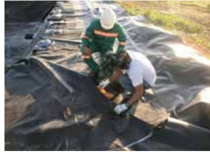
b) Soldadura de la geomembrana.
