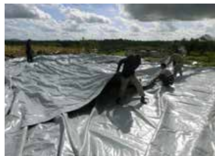
h) Instalación de la membrana externa.
