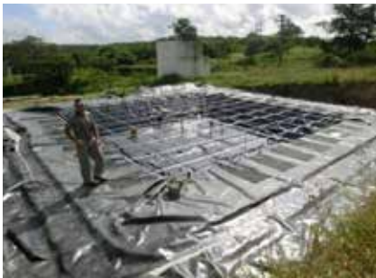
c) Instalación de cinturones de sujeción para la red de nylon.
