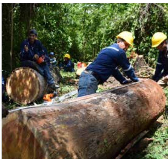
Medición del diámetro mayor (foto izquierda), el largo (centro) y el diámetro menor (der.) en una troza o sección
