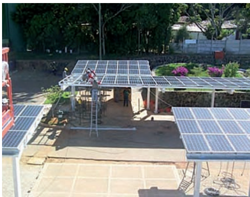
Abbildung 1: Das letzte Solarmodul wird auf den Parkplätzen des „Pituçu Solar“ installiert (15.03.2012)
