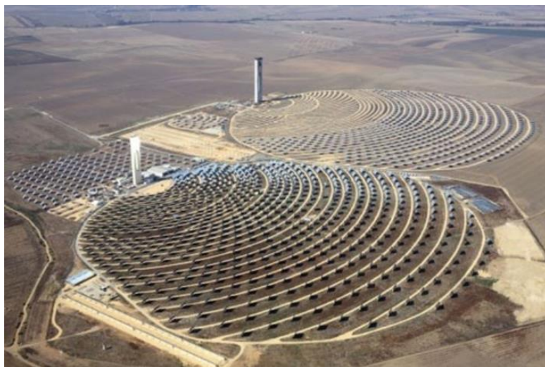
Solarna elektrana PS10 u Španiji
