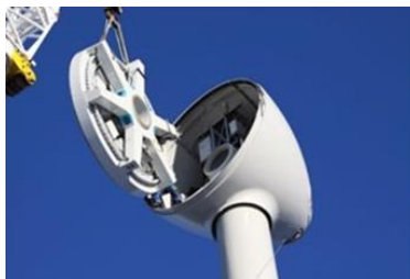
Primeri montiranja delova opreme na gondoli
