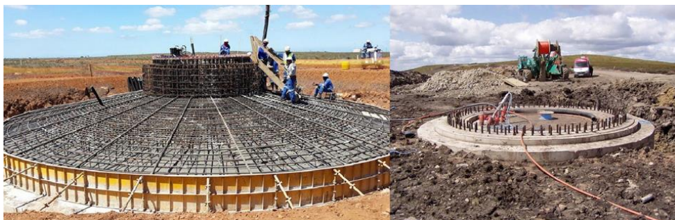
Primeri temelja vetroturbina
