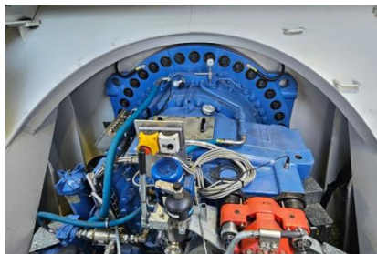
Povezivanje generatora vetroagregata
