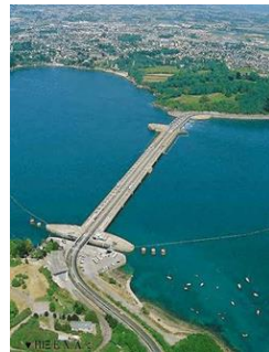
Elektrana La Rance
