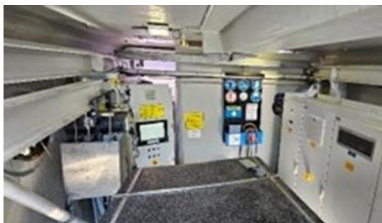
Slika: Povezivanje upravljačkog sistema vetroagregata, uključujući senzore, PLC kontroler i sistem kočenja
