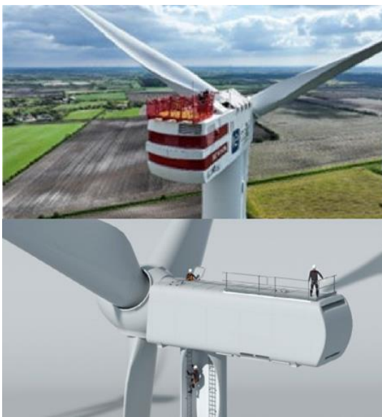
Primer sigurnosne barijere montirane direktno na vrhu gondole
