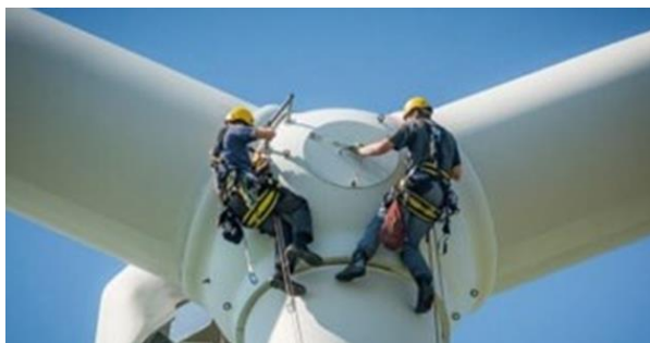
Primer sigurnosnog vezivanja za fiksne tačke za rad na visini
