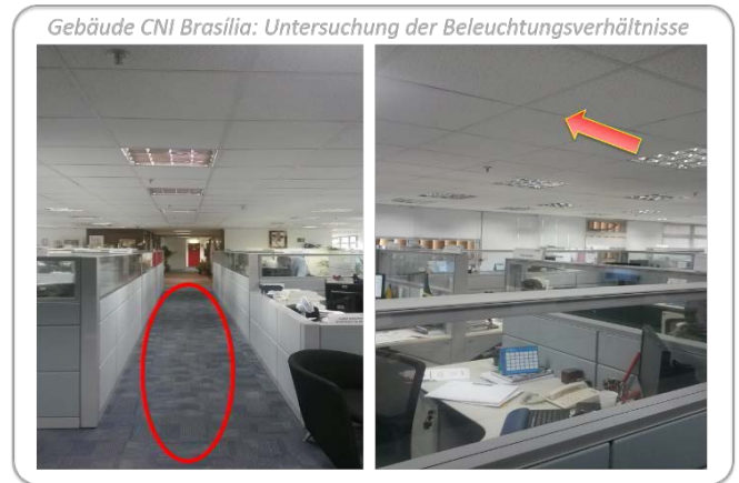
Energieeffizienzdiagnose und Schulung für SENAI Personal im Gebäude der CNI in Brasília
