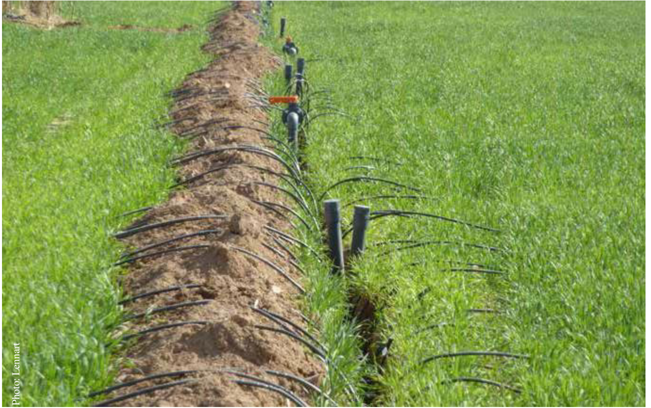
Installation d'un système d'irrigation goutte à goutte (Source : Lennart Woltering)
