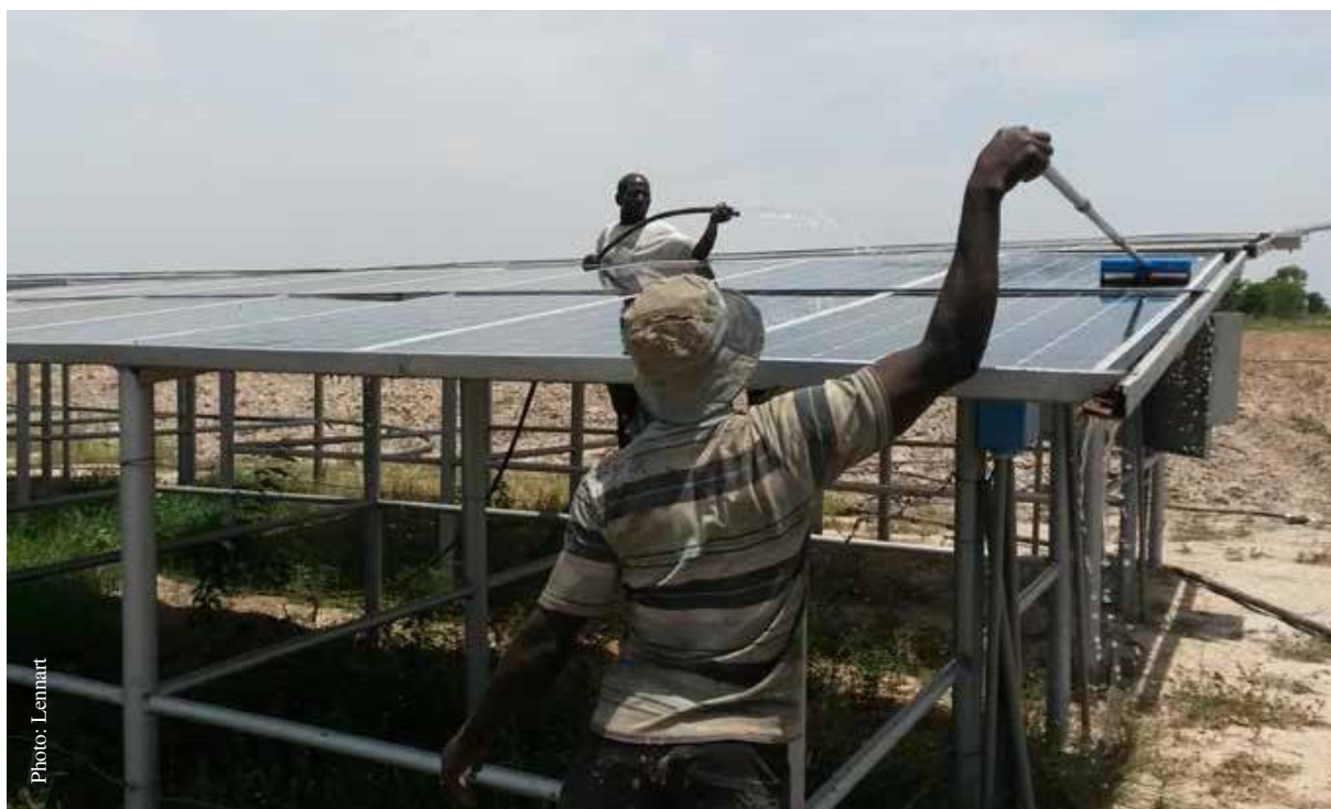
Nettoyage de panneaux solaires au Ghana dans le cadre de l'entretien courant
