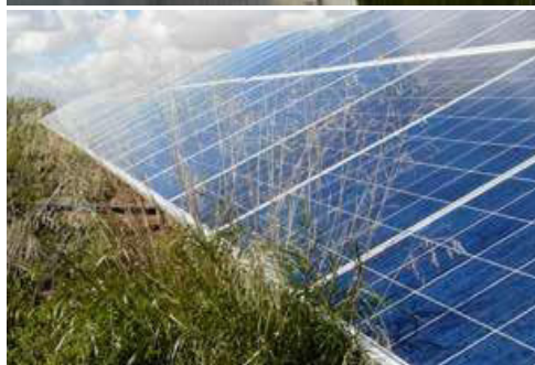
Exemple d'une connexion par câble dangereuse ; corrosion galvanique d'un système de suiveur
