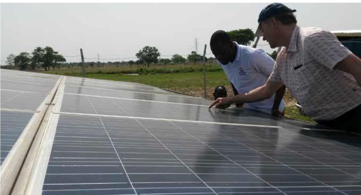
Contrôle visuel des panneaux solaires
