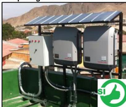
**13. El procedimiento de apagado de emergencia de la UG está visible en el costado del inversor (exigido en instrucción técnica RGR N° 02/2014)**
