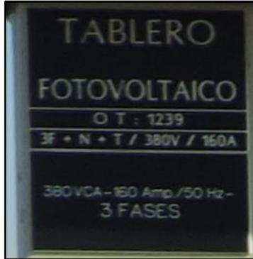
Figura 61: Ejemplo de señalización para un tablero eléctrico
