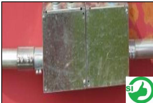
A modo de ejemplo, en la Figura 81 se muestra donde debió haberse utilizado una caja fijada a la cubierta, la cual debería haber recibido todos los cables provenientes de los módulos de forma ordenada, como se muestra en la Figura 82 y de la forma que se explica en el punto 8.2.12.8. La tubería metálica podría utilizarse a continuación de la caja.
