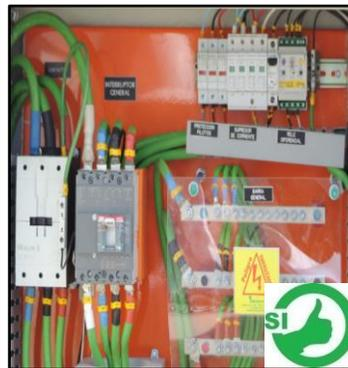
Figura 63: Ejemplo 2 de componentes rotulados, más información de apagado de la planta fotovoltaica. Sin embargo la forma utilizada para etiquetar es vulnerable a despegarse y no permanecer en el tiempo
