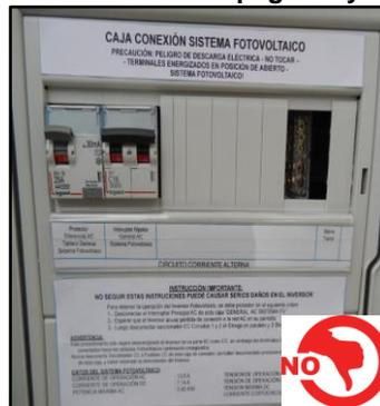
**Figura 64: Ejemplo 3, con tablero con elementos rotulados de manera insuficiente**
