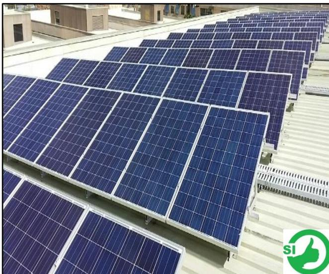
Junto con verificar que la instalación se encuentre terminada, es decir, todas las conexiones, tableros, canalizaciones, sistema de puesta a tierra, inversores conectados, string box, señalética de seguridad, entre otros. Además, debe comprobarse que todos los componentes del campo fotovoltaico se encuentran correctamente instalados y fijados y no se encuentran sometidos a esfuerzos mecánicos. Por lo tanto, el instalador debe cerciorarse de por ejemplo, que:
