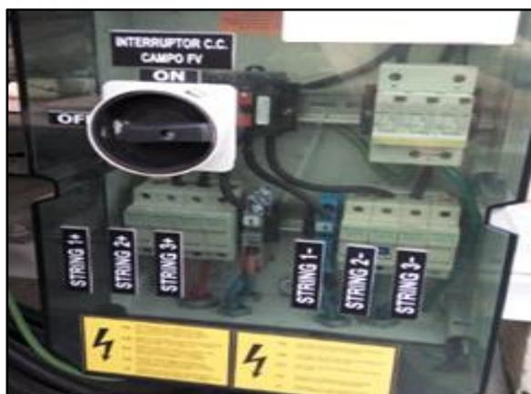
Es importante destacar con respecto al seccionador del tablero de CC, que este debe estar afuera del gabinete, de manera que no sea necesario abrir el tablero para cortar el suministro de energía como se muestra en la Figura 50: Ejemplo 2 de tablero de CC. Finalmente, el tablero debe contar con una señal de advertencia que debe decir: Las piezas activas pueden tener todavía corriente continua peligrosa después de la separación del inversor fotovoltaico - IEC 60364-7-712:2002.
