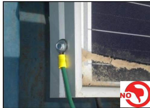
**Figura 115: Puesta a tierra incorrecta, utilizando la grapa y el marco de los módulos (no permitido). Además, el conductor para la puesta a tierra debe ser resistente a la humedad y a los rayos UV.**
