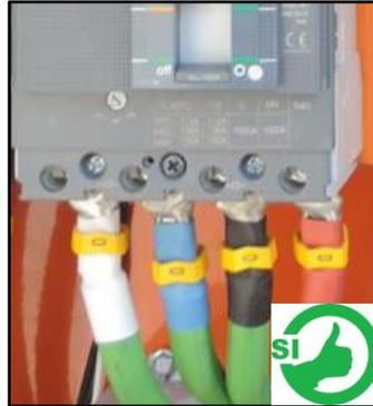
**16. El conductor utilizado es del tipo PV, PV1-F, Energyflex, Exzhellent Solar ZZ-F (AS), XZ1FA3Z-K (AS) o equivalente. (Norma TÜV 2 pfg 1169/08.2007)**
