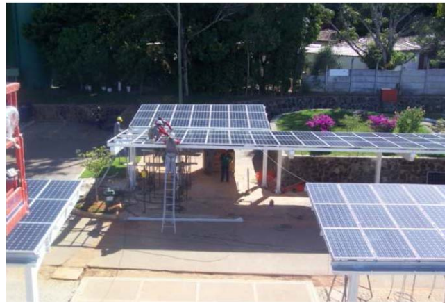
Das letzte Solarmodul wird auf den Parkplätzen des Pituacu Solar installiert (15.03.2012).
