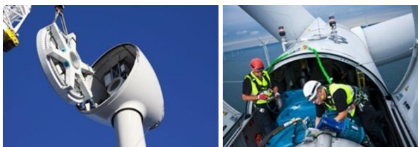
Примери за монтирање на делови од опрема на гондолата
