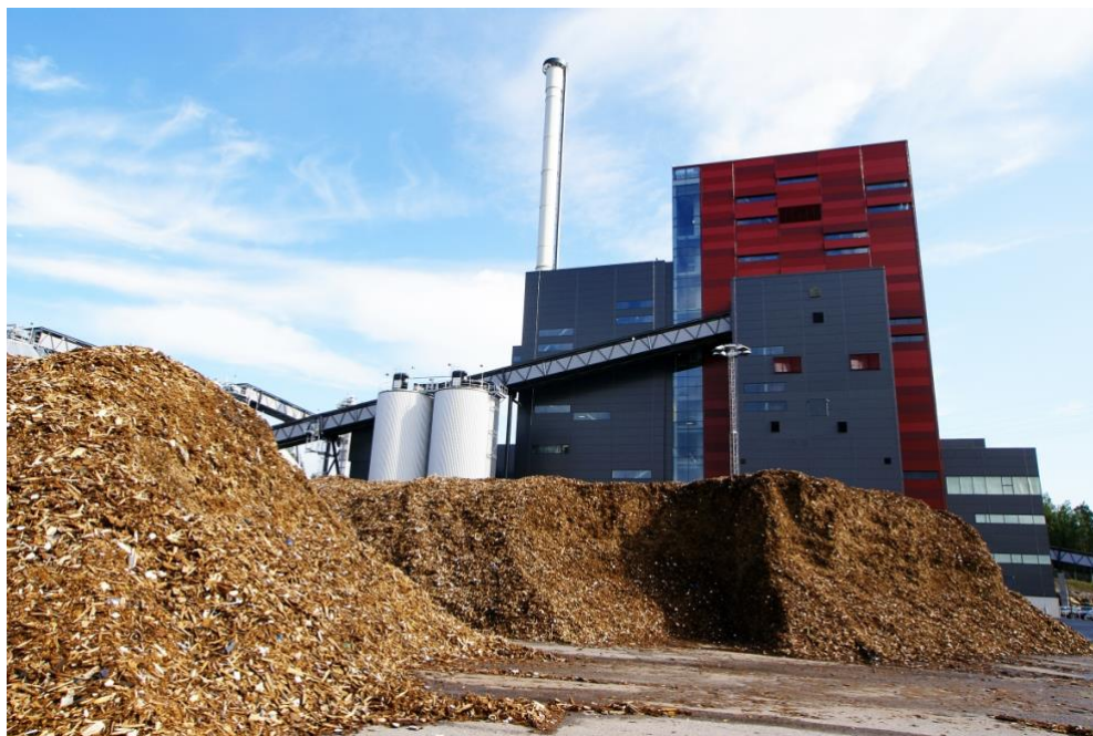
Foto: Capacitación a profesionales sobre sistemas de cogeneración con biomasa.
