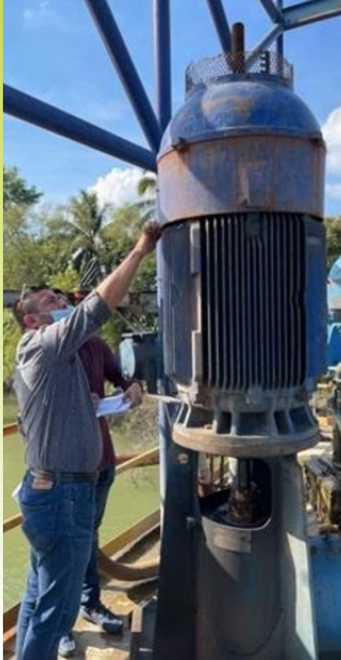
Fotografía 6: Visita técnica bombeo
