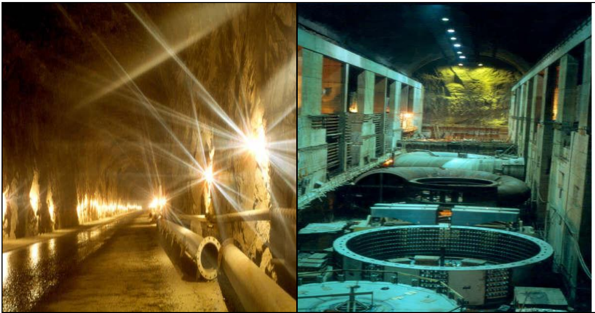
Figura 4: Caverna Escavada na rocha a esquerda e Turbinas a Direita da existente Central Sul
