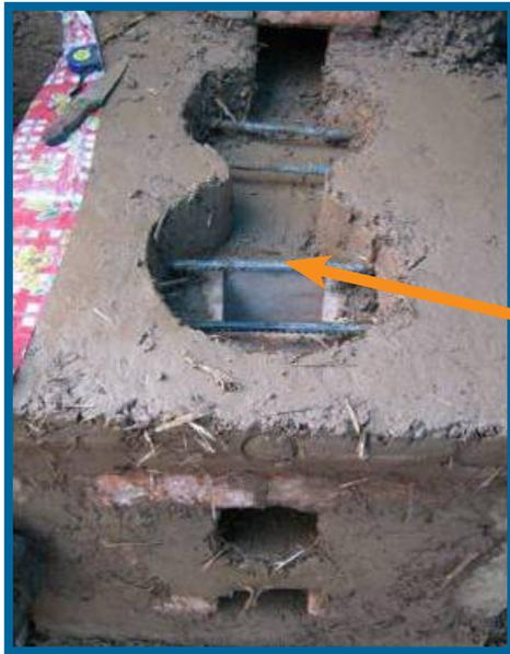
*Fierro corrugado de 1/2"*: utilizado para fabricar los soportes de las ollas en las dos hornillas. Se trata de cuatro piezas de 45 centímetros cada una que son colocadas dos en cada hornilla, con una separación de 10 centímetros.
