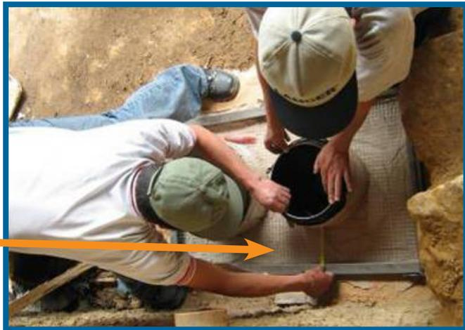
Malla electrosoldada utilizada como alma de losa de concreto
