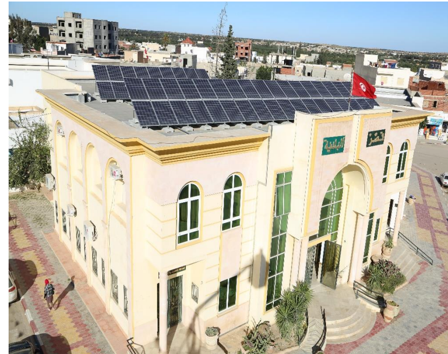
14 kwc – Municipalité de Agreb Concours Régional 'Sfax- l'Avenir pour l'énergie Solaire'
