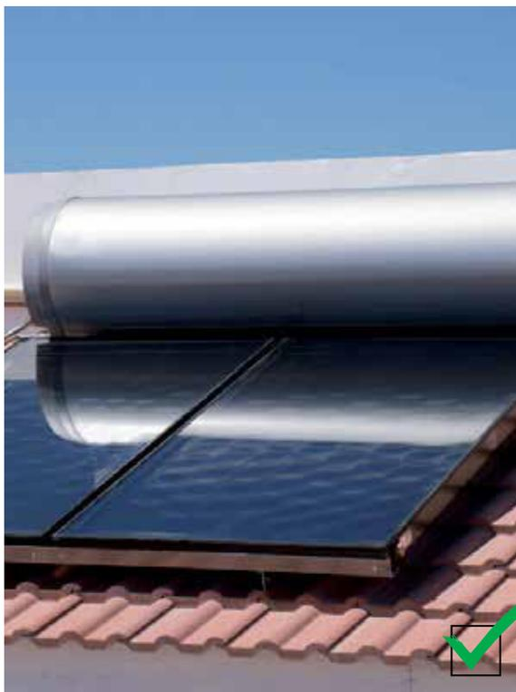
Les chauffe-eaux solaires doivent profiter d'un maximum d'ensoleillement et éviter l'ombrage. Portez attention au minaret qui peut faire de l'ombre. D'autre part, la distance entre le chauffe-eau solaire et le robinet d'utilisation doit être minimisée pour éviter la pose de longs tuyaux et les pertes thermiques qui y sont liées. Il faut avoir un accès facile au chauffe-eau solaire pour l'entretien.
