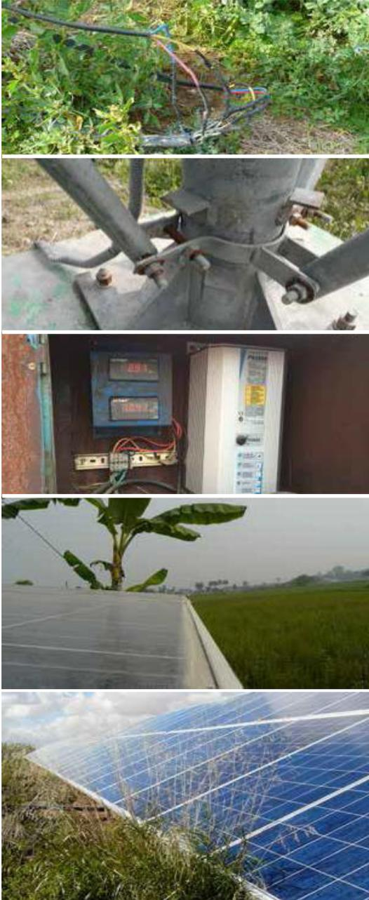
Conexión peligrosa de cables, corrosión galvánica de un sistema de seguimiento manual, capacidad limitada de disipación de calor de la carcasa corroída de un controlador; ejemplos de mantenimiento inadecuado: suciedad acumulada en el borde inferior del panel fotovoltaico, sombras sobre un panel fotovoltaico provocadas por falta de mantenimiento de la cubierta vegetal del suelo (Fuente: Andreas Hahn, 2015)
