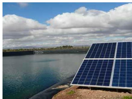
**Reservorio de agua abierto impermeabilizado con lámina de plástico**
