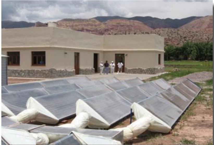
En la Figura 25 se puede observar una batería de paneles solares que captan la energía calórica del sol y en combinación con ventiladores eléctricos, generan flujos de aire caliente los cuales son utilizados en procesos de deshidratación en cabinas bajo sombra, con ello se logra ahorrar costos de generación de calor además de generar procesos limpios de gases contaminantes.
