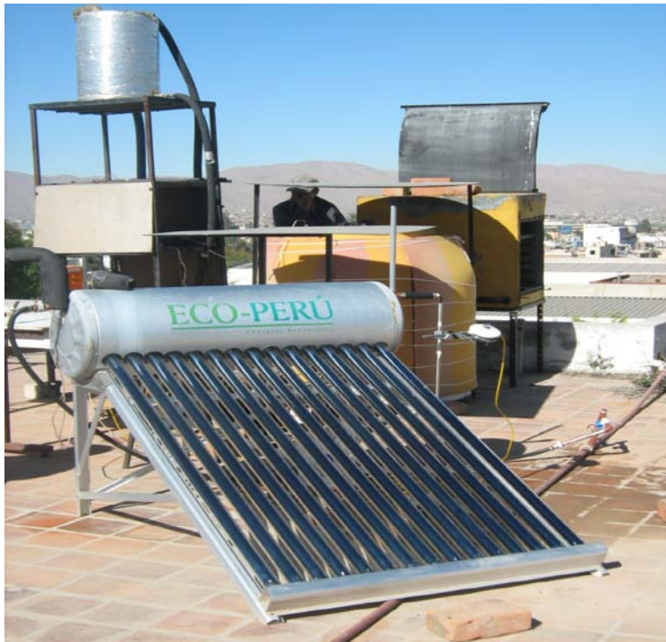
Figura 5.2 Fotografía del calentador solar
