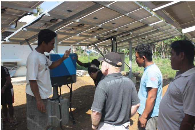
Gambar 25 Operator menjelaskan cara kerja PLTS
