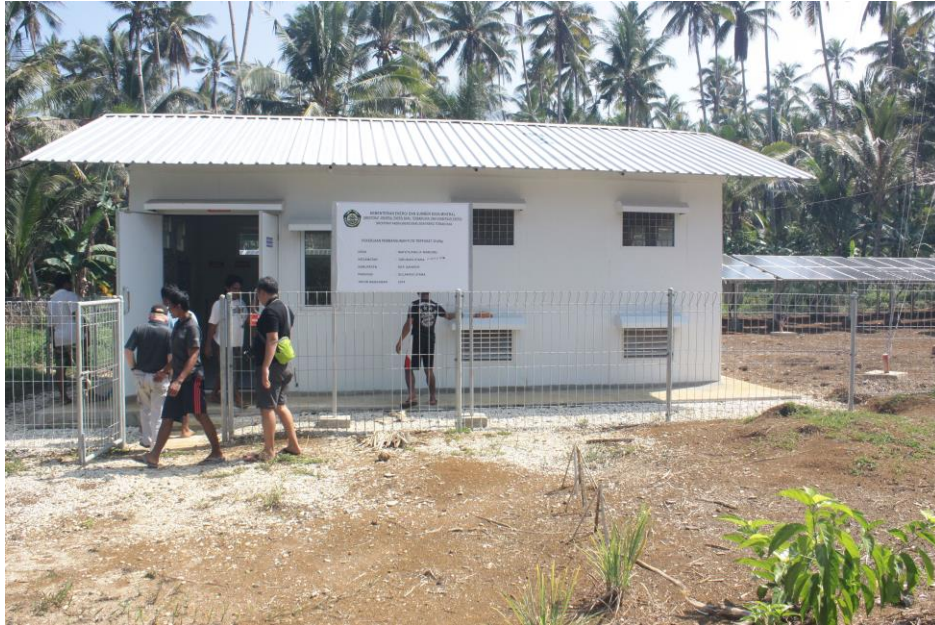
Gambar 17 Rumah pembangkit PLTS di Pulau Matutuang
