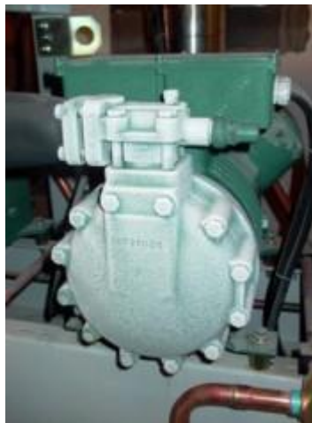
Figura 27 Compresor de doble etapa
