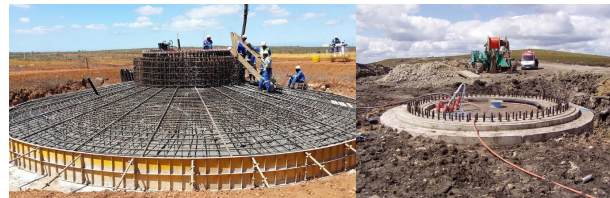
Primjeri temelja vjetroturbina
