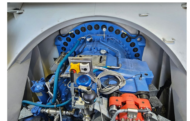
Povezivanje generatora vjetroatregata
