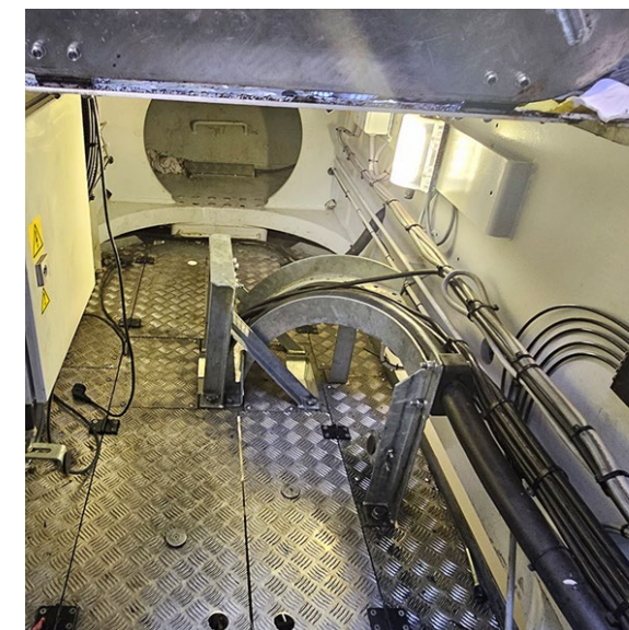
Polaganje i povezivanje napojnih kablova unutar gondole vjetroturbine
