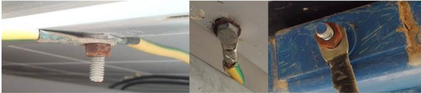
FIGURE 15: DEF AUT DE CONNEXION DE LA MALT
