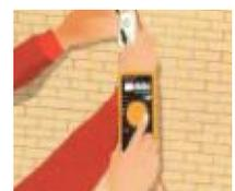
11. Con ayuda de un multímetro, compruebe la tensión en el circuito colocándolo en la escala adecuada para medir la tensión en el interruptor termomagnético, así como en los terminales del portalámpara y el interruptor.
