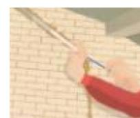
8. Prepare los terminales del conductor para conectar los accesorios.
