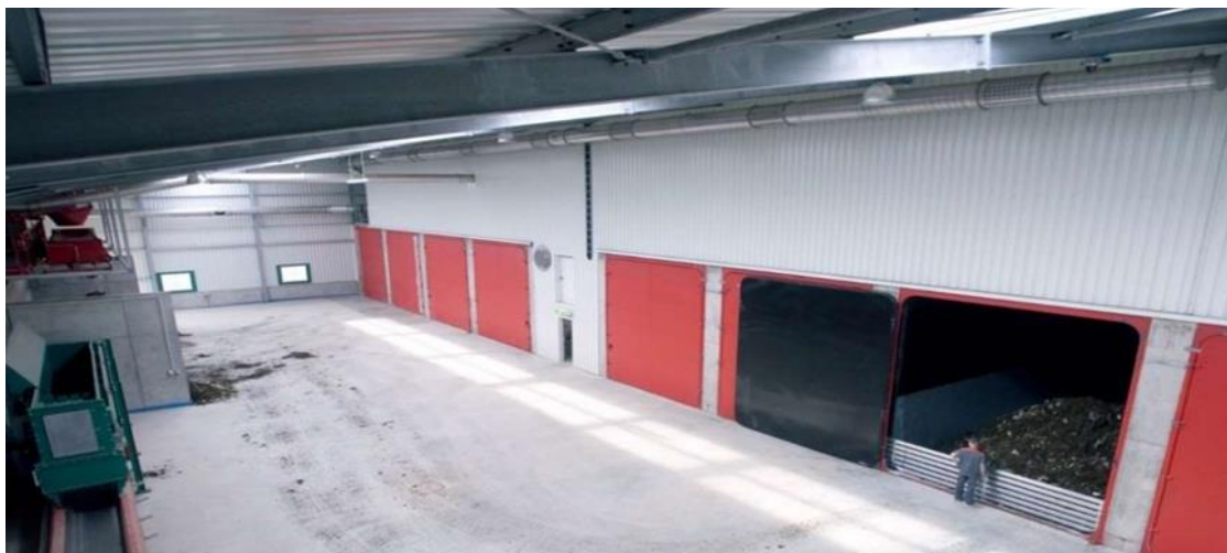
Figura 64: Vista de las puertas del fermentador con rejilla de retención.
