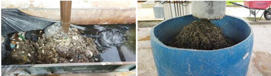
Figura 10: Retiro de Arena y otros Subproductos Resultantes del Tratamiento.
