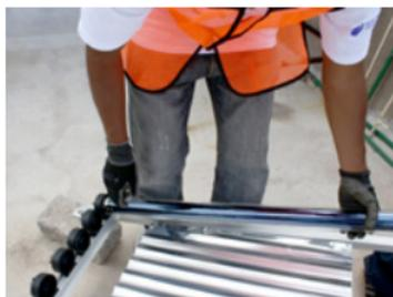
Fotografía 53. Asegure el tubo dentro del accesorio de soporte para que quede fijo.
