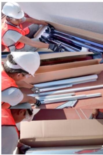
Fotografía 42. Revise que todos los elementos del CSA estén presentes y que éstos se encuentren en óptimas condiciones.
