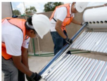
Fotografía 52. Introduzca el tubo dentro del termotanque con giros suaves.
