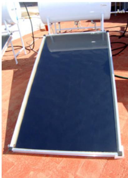
Fotografía 1. Colector solar plano
