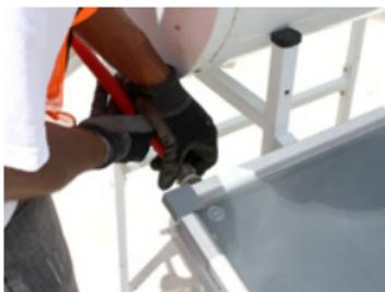
Fotografía 59. Coloque las conexiones del colector hacia el termotanque y viceversa según las instrucciones del fabricante.
