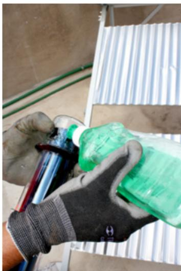
Fotografía 51. Coloque lubricante en la boca del tubo así como en el empaque.
