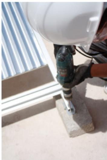
Fotografía 47. Asegure la estructura del CSA cuidando la integridad del impermeabilizante para evitar filtraciones.
