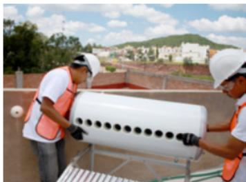
Fotografía 48. En CSA con colector de tubos evacuados, una vez instalada la estructura se coloca el termotanque.
