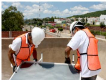
Fotografía 55. Asegure el colector a la estructura de soporte, orientando el colector hacia el sur.
