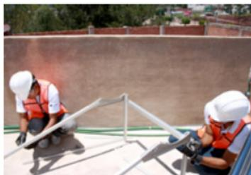
Fotografía 44. Arme la estructura y asegure toda la tornillería.
