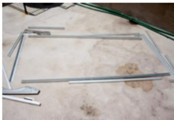
Fotografía 43. Despliegue las piezas de la estructura y ubique la tornillería.
