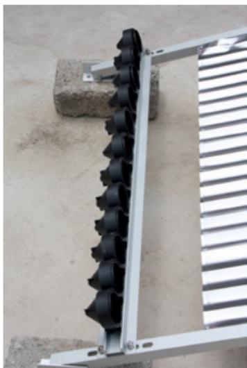
Fotografía 50. Coloque los accesorios de soporte de los tubos evacuados.
