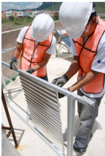
Fotografía 45. Coloque los reflectores y asegure la tornillería (CSA colector de tubos evacuados).
