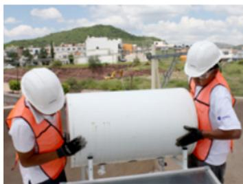
Fotografía 57. Coloque el termotanque en la estructura.
