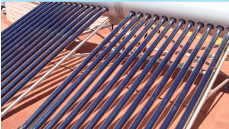
Fotografía 2. Colector solar de tubos evacuados.
