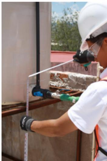
Fotografía 39. Revisar que la altura de la base del tinaco sea la necesaria (Instalaciones con tinaco).
