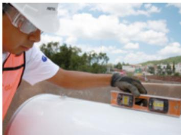
Fotografía 49. Revise el nivel de termotanque.
