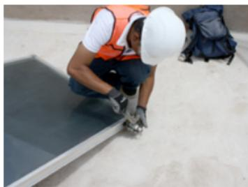
Fotografía 56. Coloque la válvula anticongelante en el colector.
