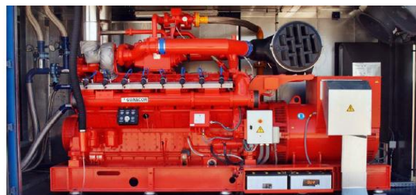
Figura 4-144. Motogenerador utilizado en el sistema de cogeneración
