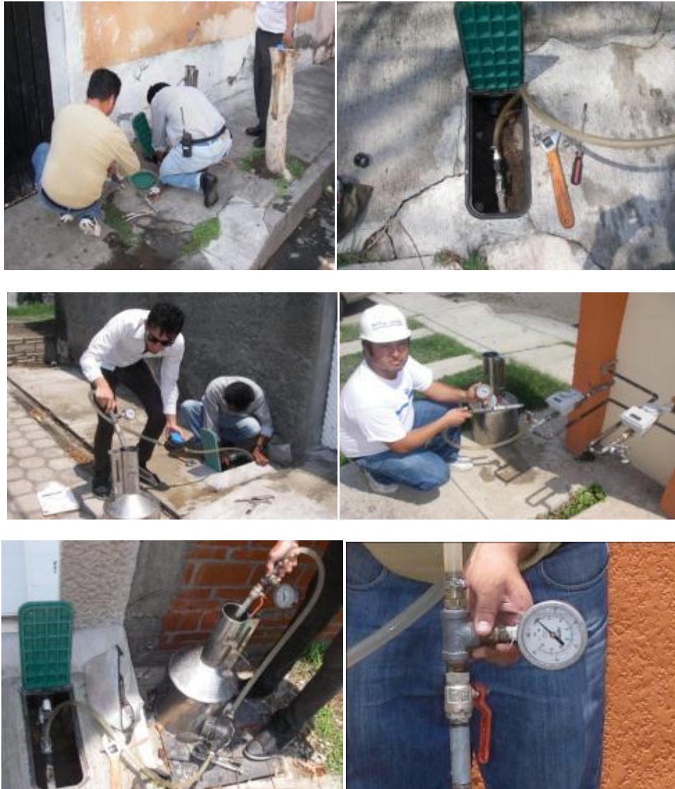
Figura 4-52. Actividades de registro de presiones en tomas domiciliarias.
