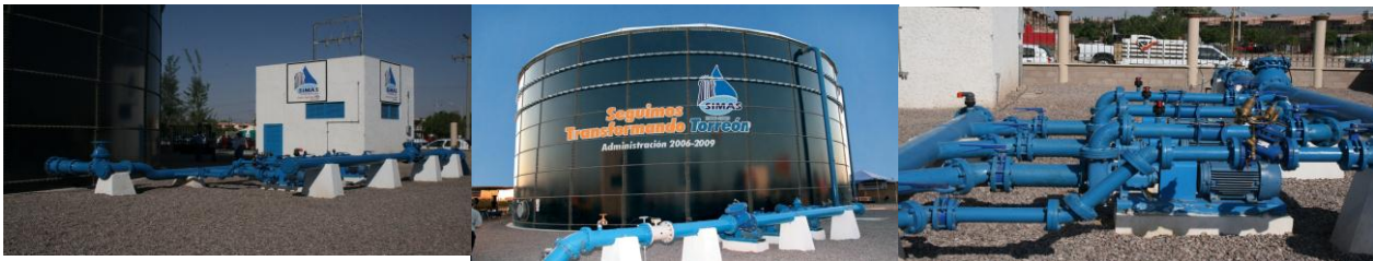
Figura 4-48. Imagenes complementarias de la implementación de proyecto de sectorización.
