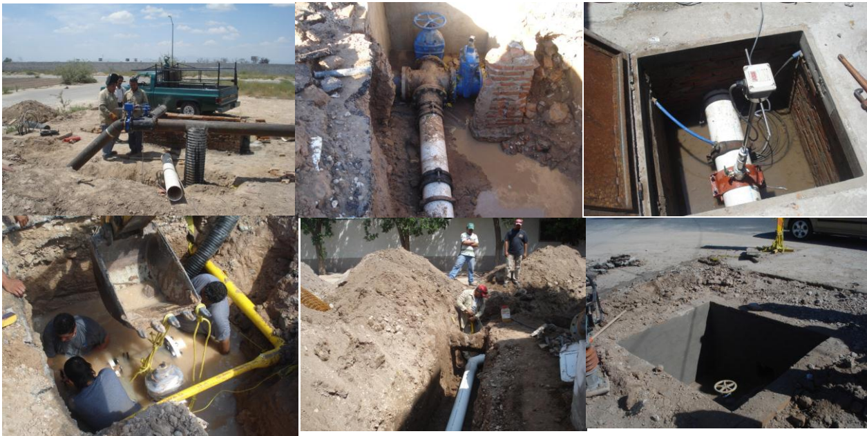
Figura 4-47. Imágenes ejemplo en la construcción de sectores.
