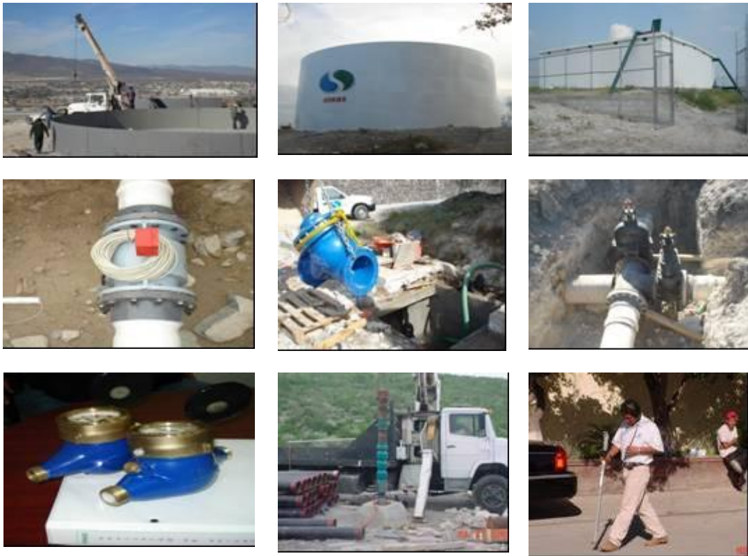
Figura 4-7. Obras y equipamiento de la implementación del proyecto de Eficiencia
