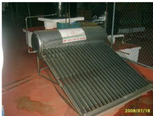
Figura 9. Sistema de calentamiento solar de agua con tubos evacuados.
