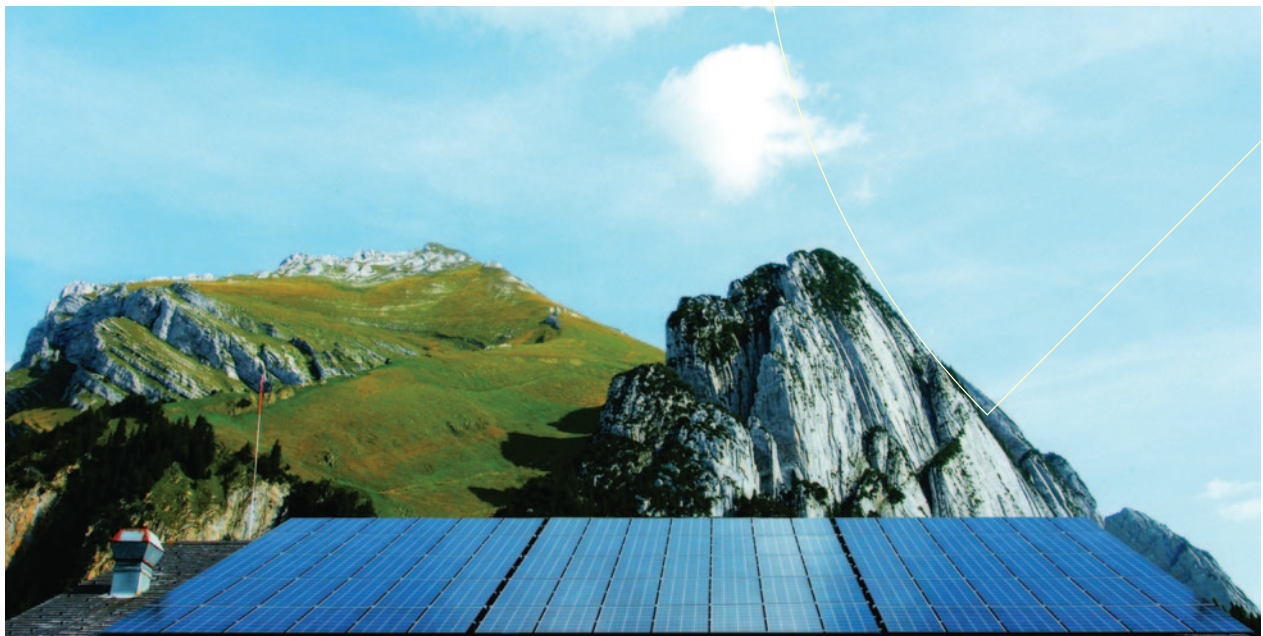
Leyenda de la foto: Instalación fotovoltaica en montaña. © Kyocera Fineceramics, Stromaufwart Photovoltaik GmbH
