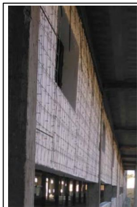
Photo 6: Parois d'un bâtiment d'élevage isolées en polystyrène armé
