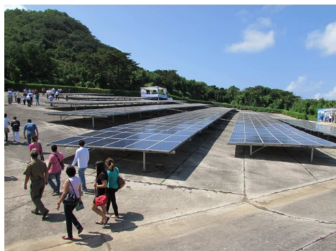
Erste PV-Anlage auf Fernando de Noronha mit einer Leistung von 420 kWp
