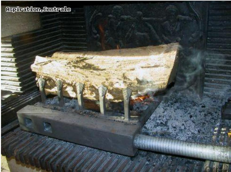
Le principe est simple: un gros serpentín de fonte est placé sous les buches. Il est donc recouvert des braises.
