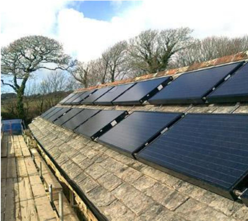
Au Royaume Uni, une installation de 28m<sup>2</sup> de panneaux PowerVolt produit l'équivalent de 38m<sup>2</sup> de cellules photovoltaïques monocristallines classiques et 8m<sup>2</sup> de capteurs solaires thermiques classiques.
