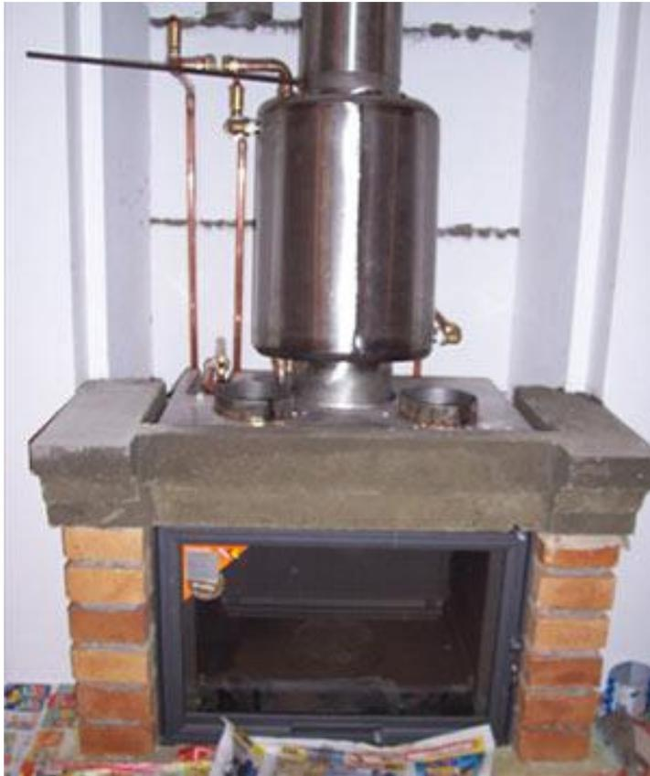
Ce type d'échangeur est placé au dessus de la cheminée.
