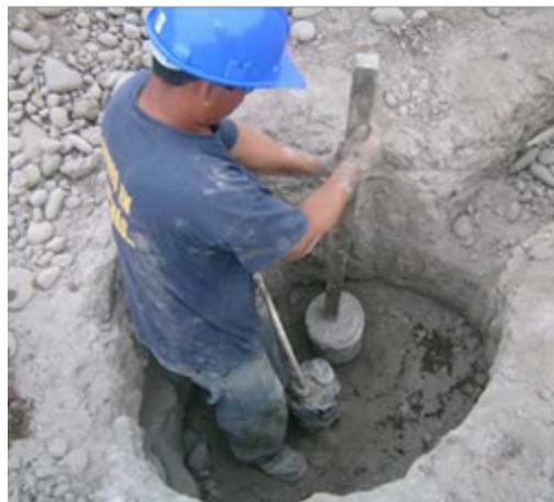
*El procedimiento de usar el aditivo (gel) es colocarlo en el pozo mediante capas, es decir capas ligeras de gel seguida de capas de tierra orgánica. La proporción es de 1 a 3 por cada metro cúbico de tierra. Conforme se va colocando las capas se debe compactar la tierra.*
