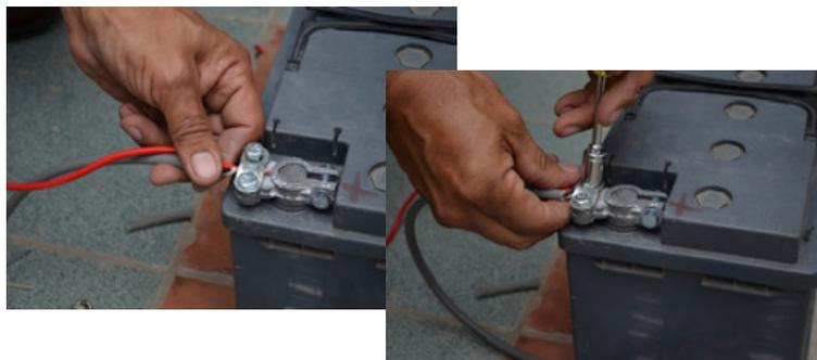
Recuerde que debe repetir la operación dos veces, pues se necesita un cable para el borne negativo y otro para el borne positivo de la batería.
