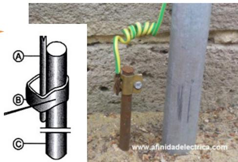
*Para finalizar la instalación del PAT, realice la conexión de la puesta a tierra con la estructura del panel fotovoltaico, tal como se muestra en la figura.*
