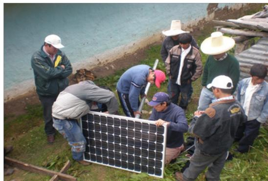
Por el modelo de sistema fotovoltaico usado y promovido por las organizaciones que impulsan el curso, se trabajará básicamente en base a panel solar montado en un poste, pero considere que los paneles también pueden instalarse sobre el techo de las viviendas y en otras estructuras según su diseño o las características de las viviendas o comunidades donde se instale.
