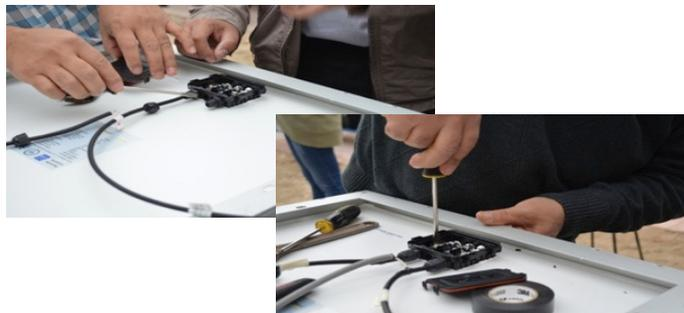
Para la instalación del sistema fotovoltaico, se utilizaran cables estándares 14 en rojo para el polo positivo y en negro para el polo negativo.
