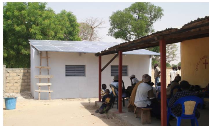
4 kWp Solarsystem für Gesundheitszentrum, Senegal
