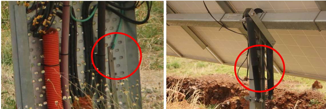
Figure 141: Equipotential bonding system
