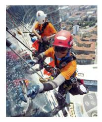
Esta acción implica que un trabajador es autosuficiente para realizar su propio descenso. Deberá realizarse siempre teniendo una cuerda B sobre la que se tendrá dispuesto un sistema anticaidas deslizante unido con absorbedor el cual estará directamente emplazado al arnés del trabajador.
