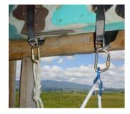
En trabajos de Altura se trabaja sobre anclajes Artificiales, los cuales ya están determinados para la realización de los trabajos, o son instalados sobre puntos fijo específicos.
