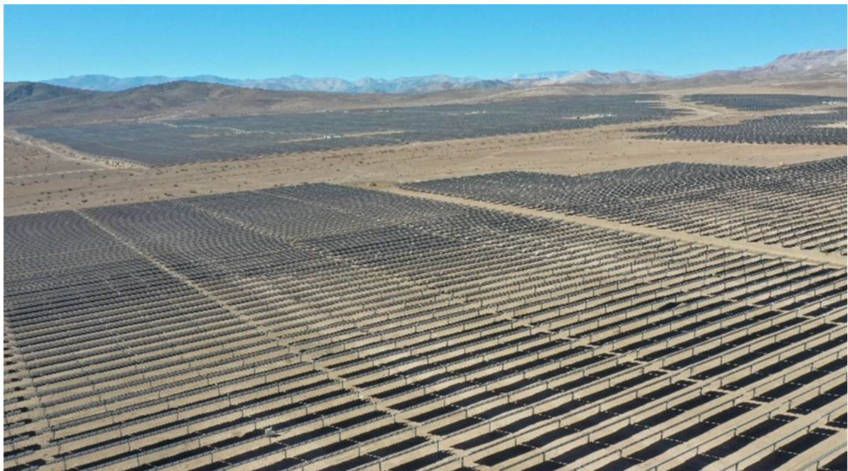
Foto: Central fotovoltaica en el Desierto de Atacama (@Ministerio de Energía de Chile)
