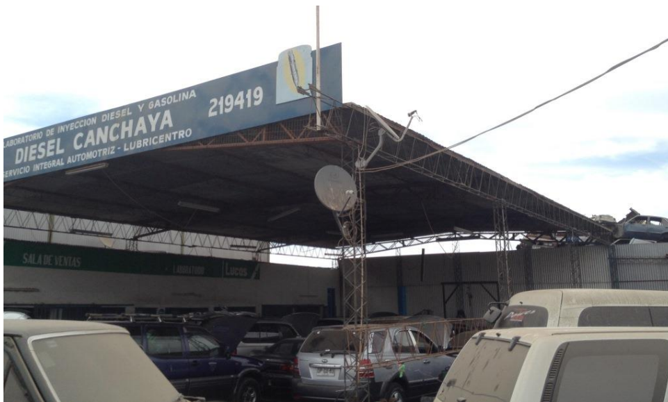
Ilustración 18: Lugar de instalación del generador solar
