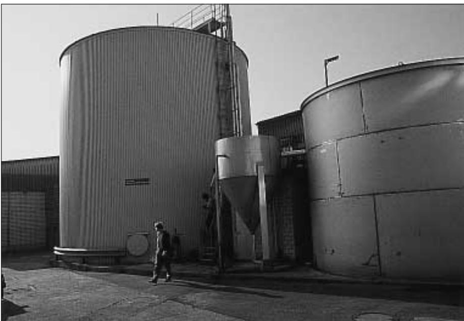
Abb. 4: Ansicht der bestehenden Anlage nach dem Kontaktverfahren: v.l.n.r. Fermenter, Sedimentation, Belüftung
